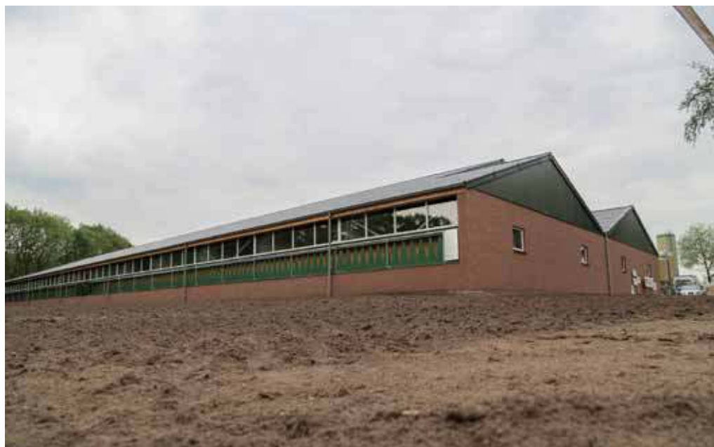
Van Spreuwel zette een nieuwe stal bij zijn bedrijf. De bouwkosten inclusief randvoorzieningen zoals een noodaggregaat schatten de ondernemers op zo'n €425 tot €450 per plaats. FOTO'S: MATTHIJS VERHAGEN
