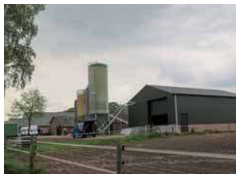
In een nieuw gebouwde loods plaatsten de ondernemers de voerinstallatie. Dat geeft ruimte om in de toekomst grondstoffen te voeren.
