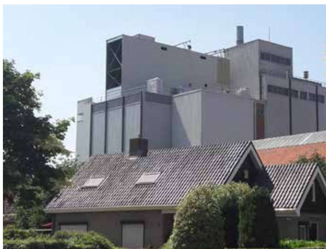
Dakopbouw locatie Markelo
