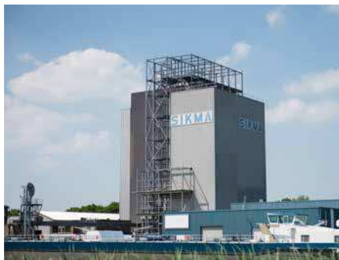
Dakopbouw locatie Stroobos
