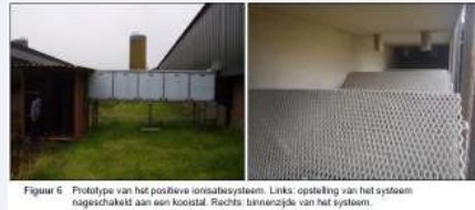
Figuur 5 Prototype van het positieve ionisatiesysteem. Links: opstelling van het systeem nageschakeld aan een kooistal. Rechts: binnenzijde van het systeem.
