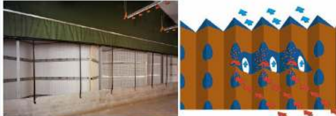
Figuur 4 Links: opstelling van de droogfilterwanden tussen vleeskuikenstal en achtergevel met ventilatoren. Rechts: schematische weergave van de luchtstromen en het filter. Rode pijlen: ingaande lucht, blauwe pijlen: uitgaande lucht. (Bron: brochure, Big Dutchman)
